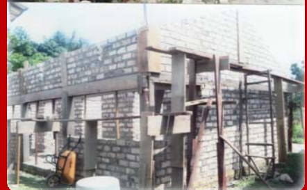
L'avancée des travaux à la maternité d'Epéna
